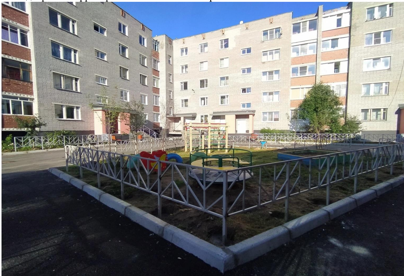
Фото дворовой территории после выполнения работ
