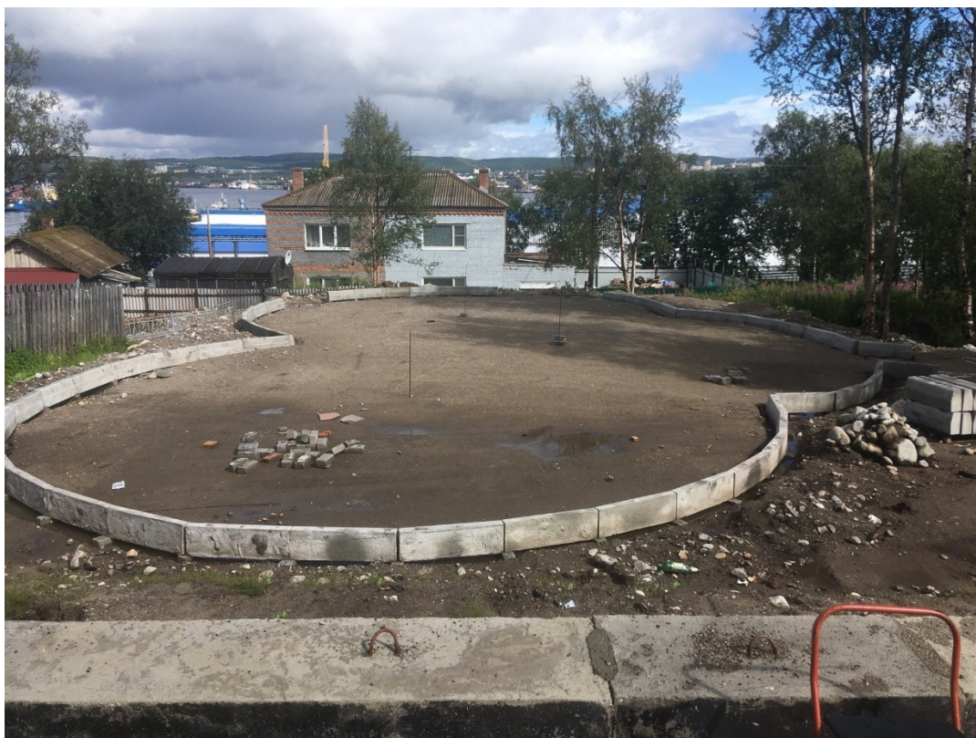
После проведения работ
