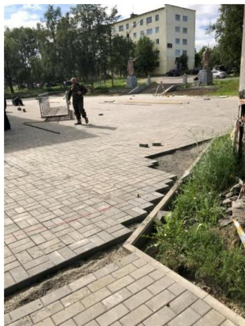
**Устройство покрытий из брусчатки по готовому подстилающему слою.**
