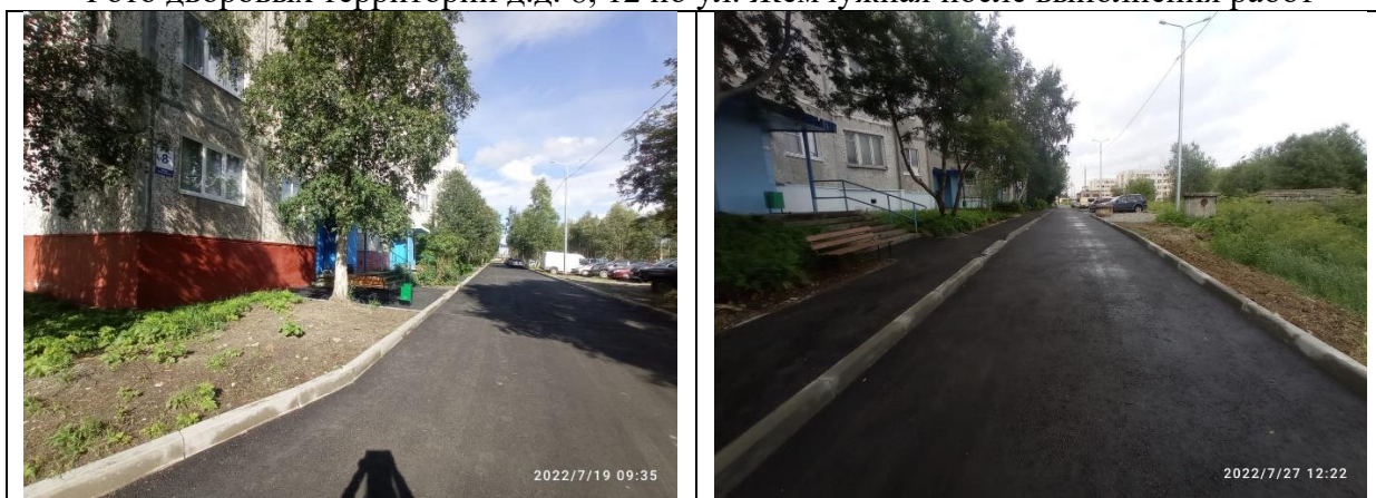
Фото дворовых территорий д.д. 8, 12 по ул. Жемчужная после выполнения работ
