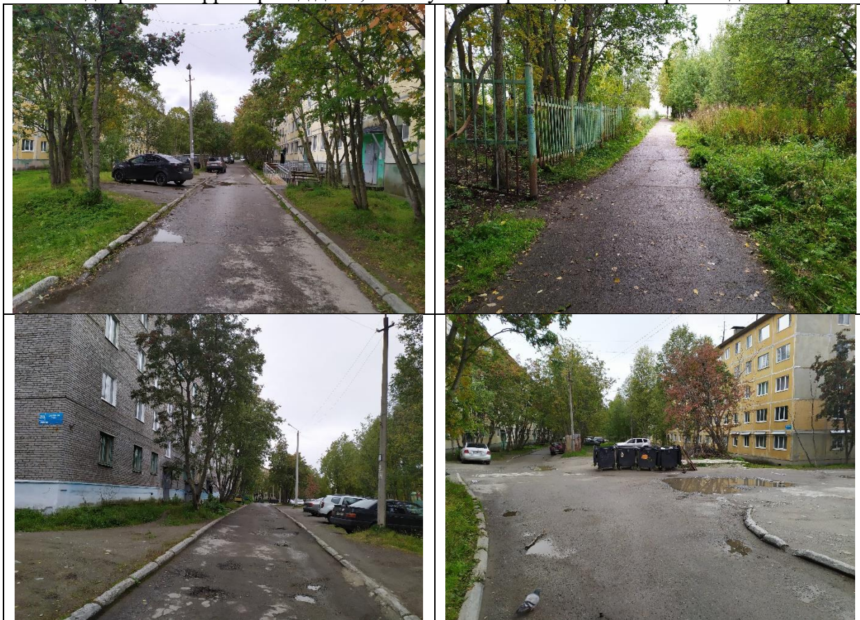
Фото дворовых территорий д.д. 26, 28 по ул. Северная до начала производства работ
