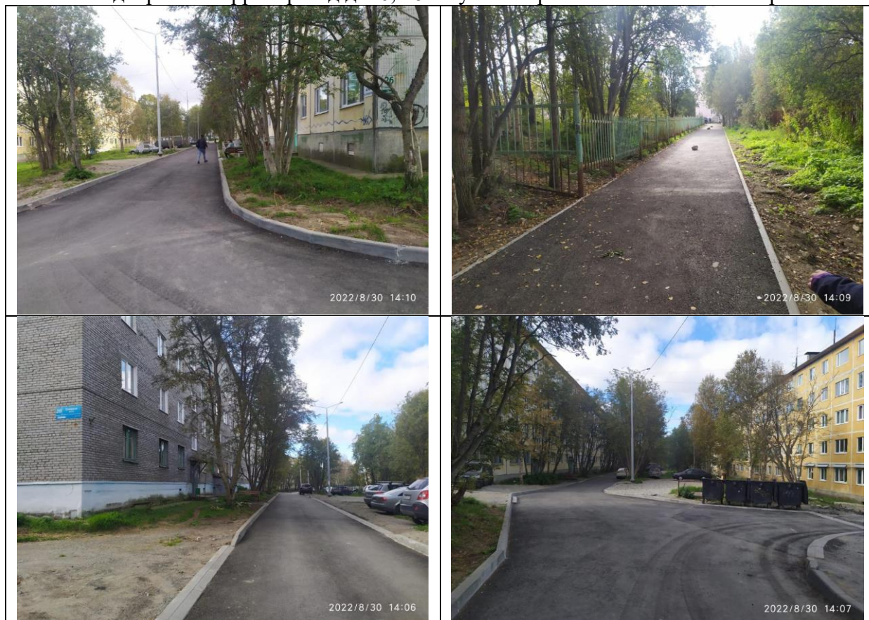
Фото дворовых территорий д.д. 26, 28 по ул. Северная после выполнения работ
