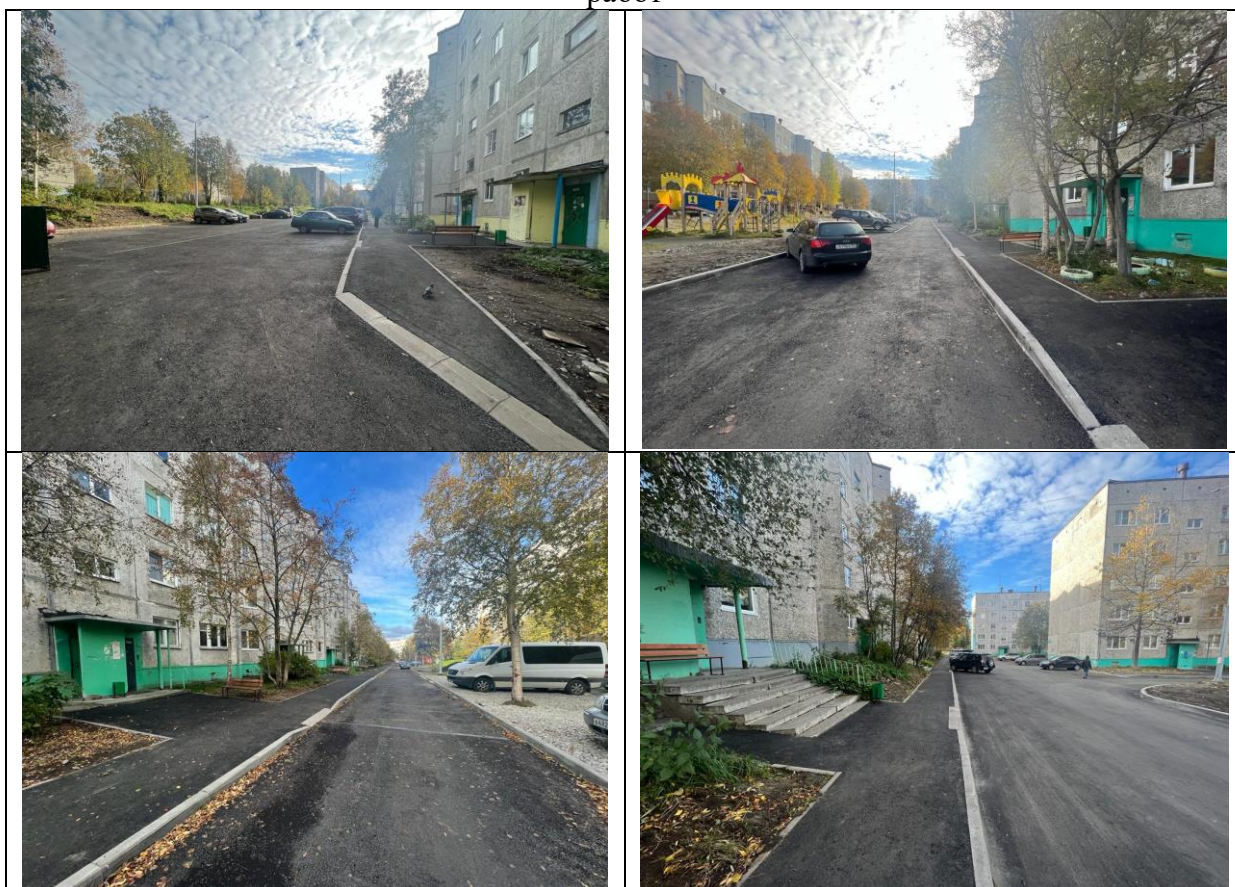
Фото дворовых территорий д.д. 47, 49, 51, 59 по ул. Дзержинского после выполнения работ
