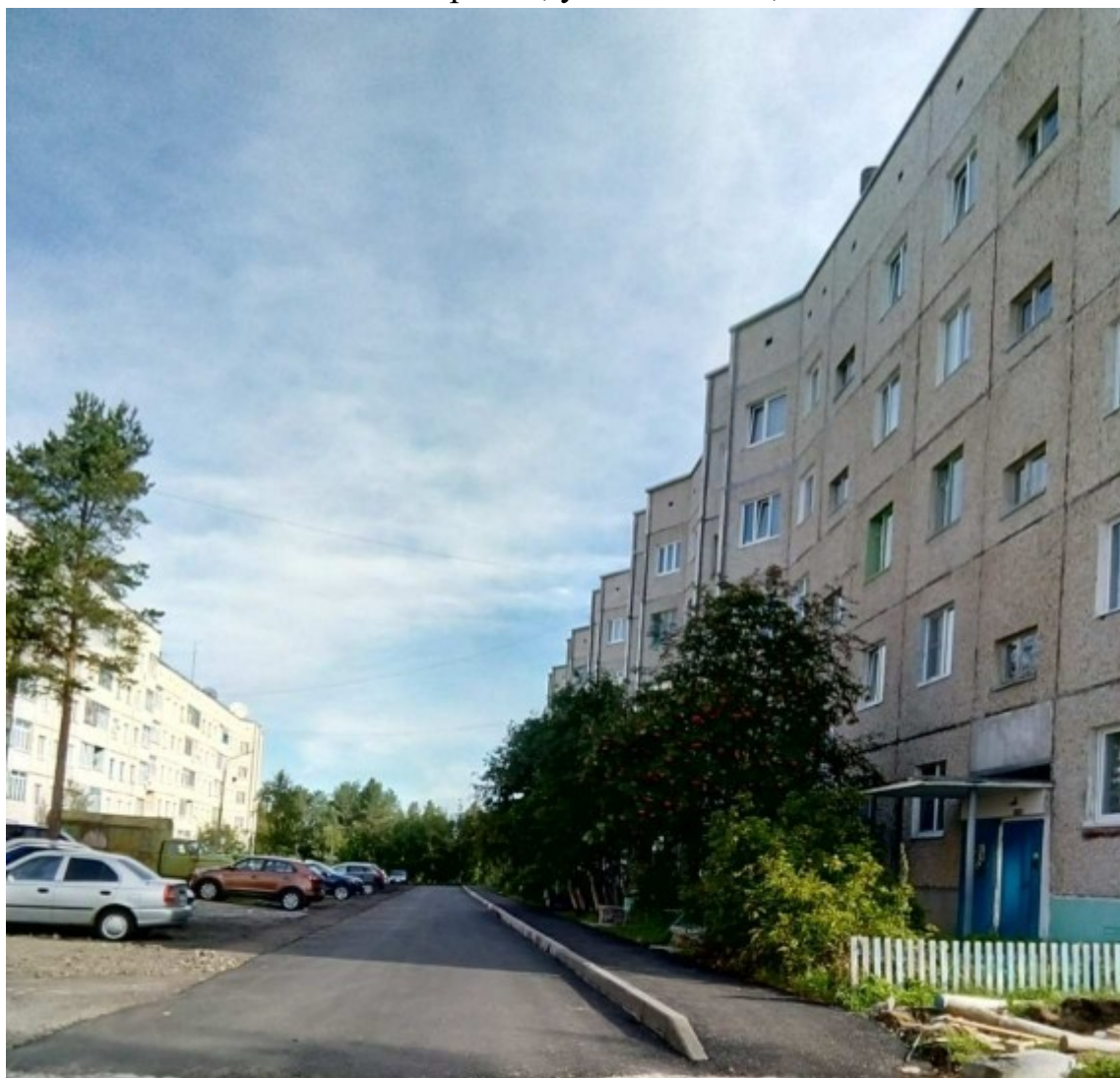
После проведения работ пгт. Зеленоборский, ул. Заводская, дом 24
