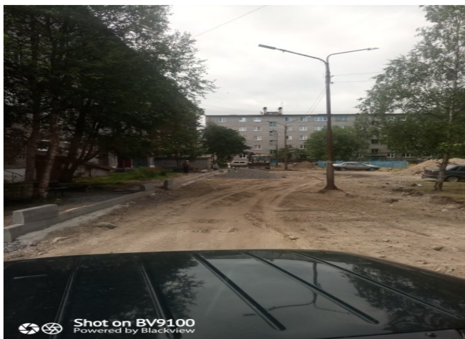
В процессе проведения работ пгт. Зеленоборский, ул. Заводская, дом 14
