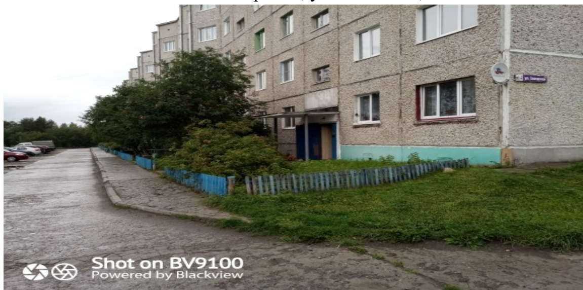
До проведения работ пгт. Зеленоборский, ул. Заводская, 24
