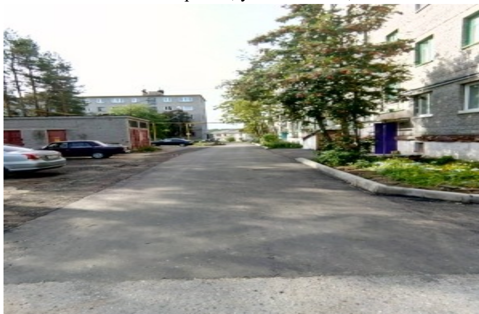
После проведения работ пгт. Зеленоборский, ул. Заводская, дом 15
