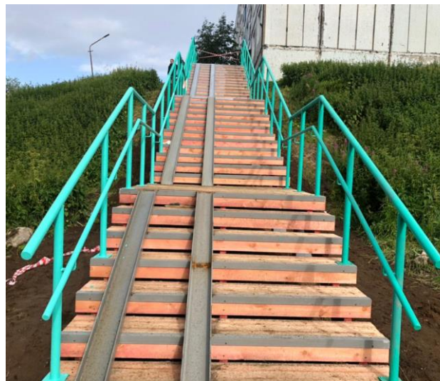
после проведения работ
