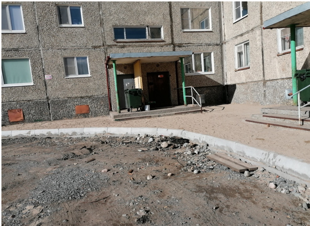
ул. Школьная, д. 5 регулированию высотного положения крышек колодцев
