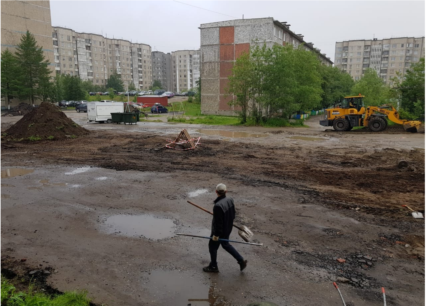
ул. Школьная, д. 5 Установка опор освещения, установка бортовых камней
