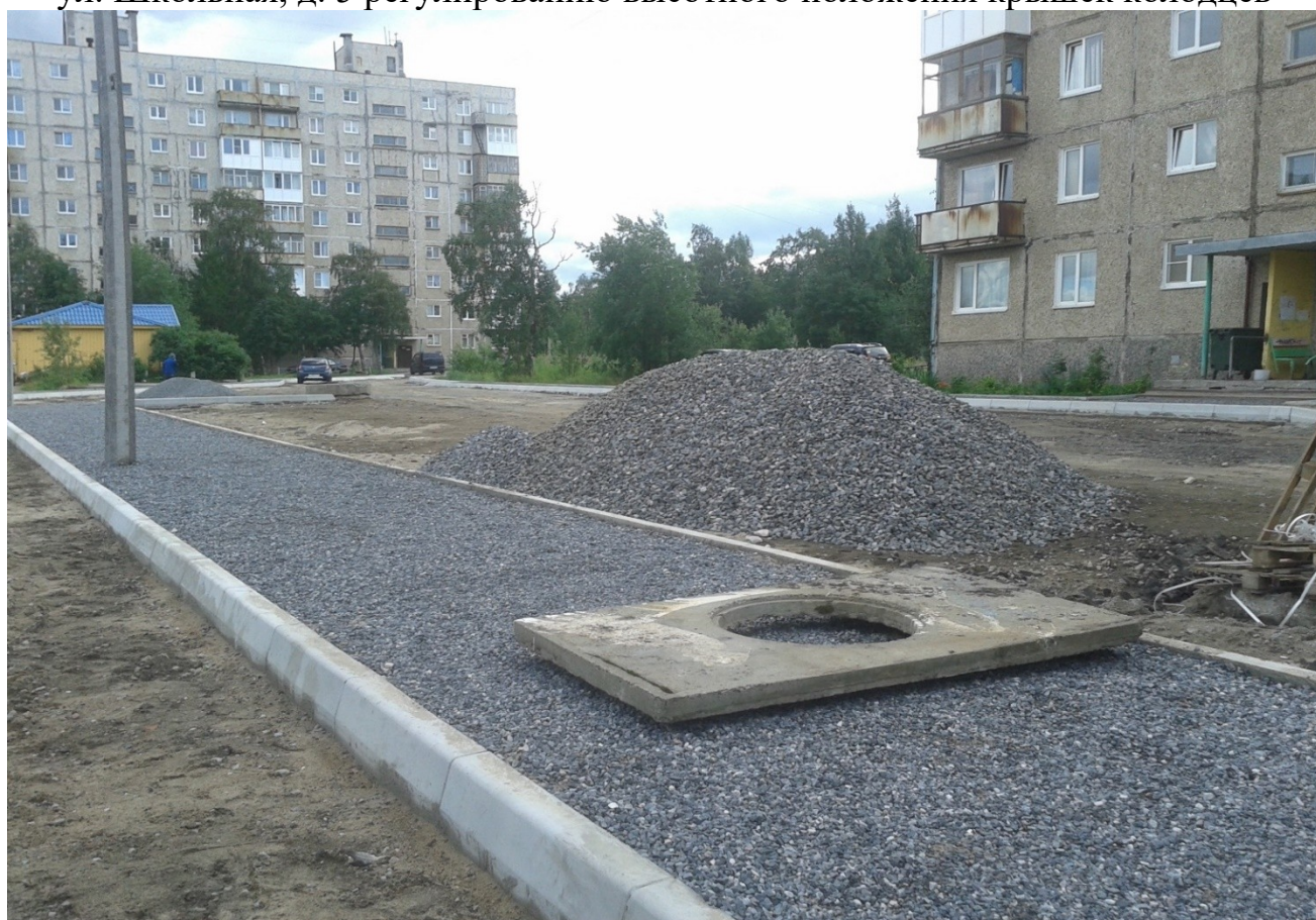
Устройство подстилающих слоев оснований из щебня
