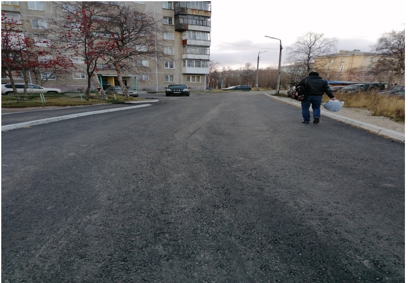
Работы на объекте завершены
