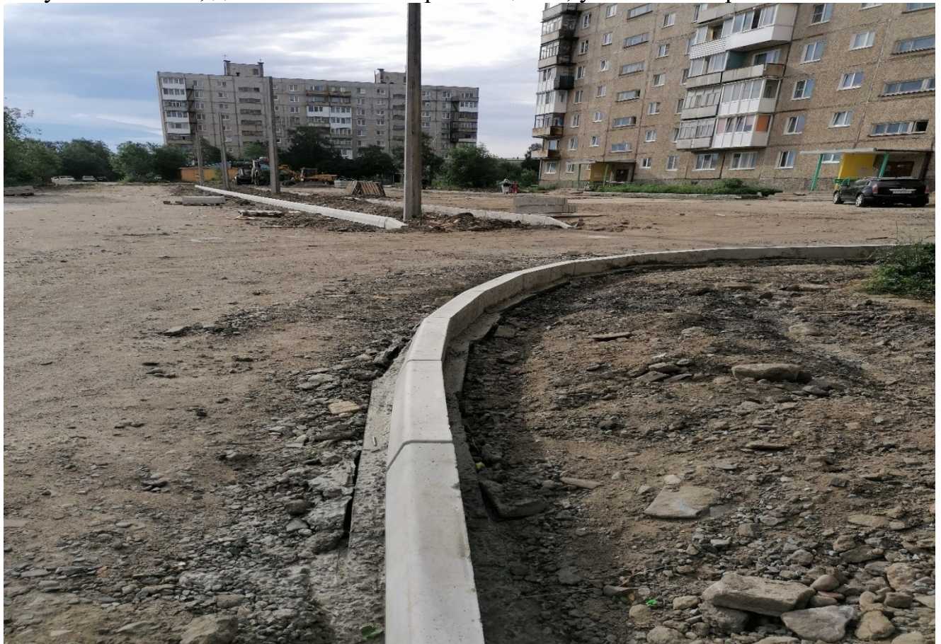
Устройство подстилающих слоев оснований из песка
