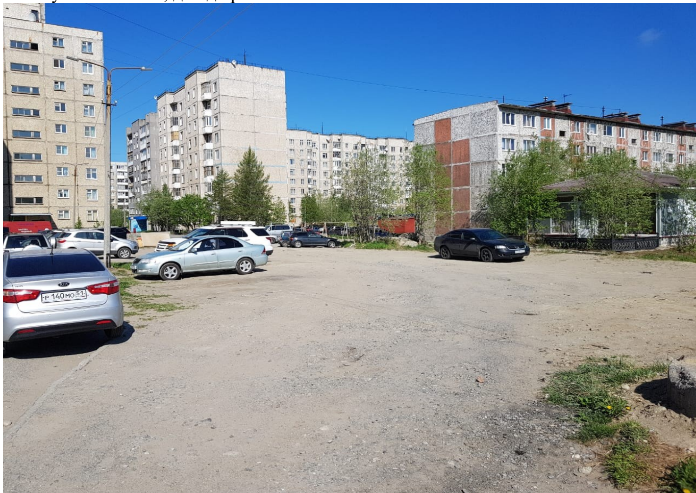
ул. Школьная, д. 5 до ремонта
