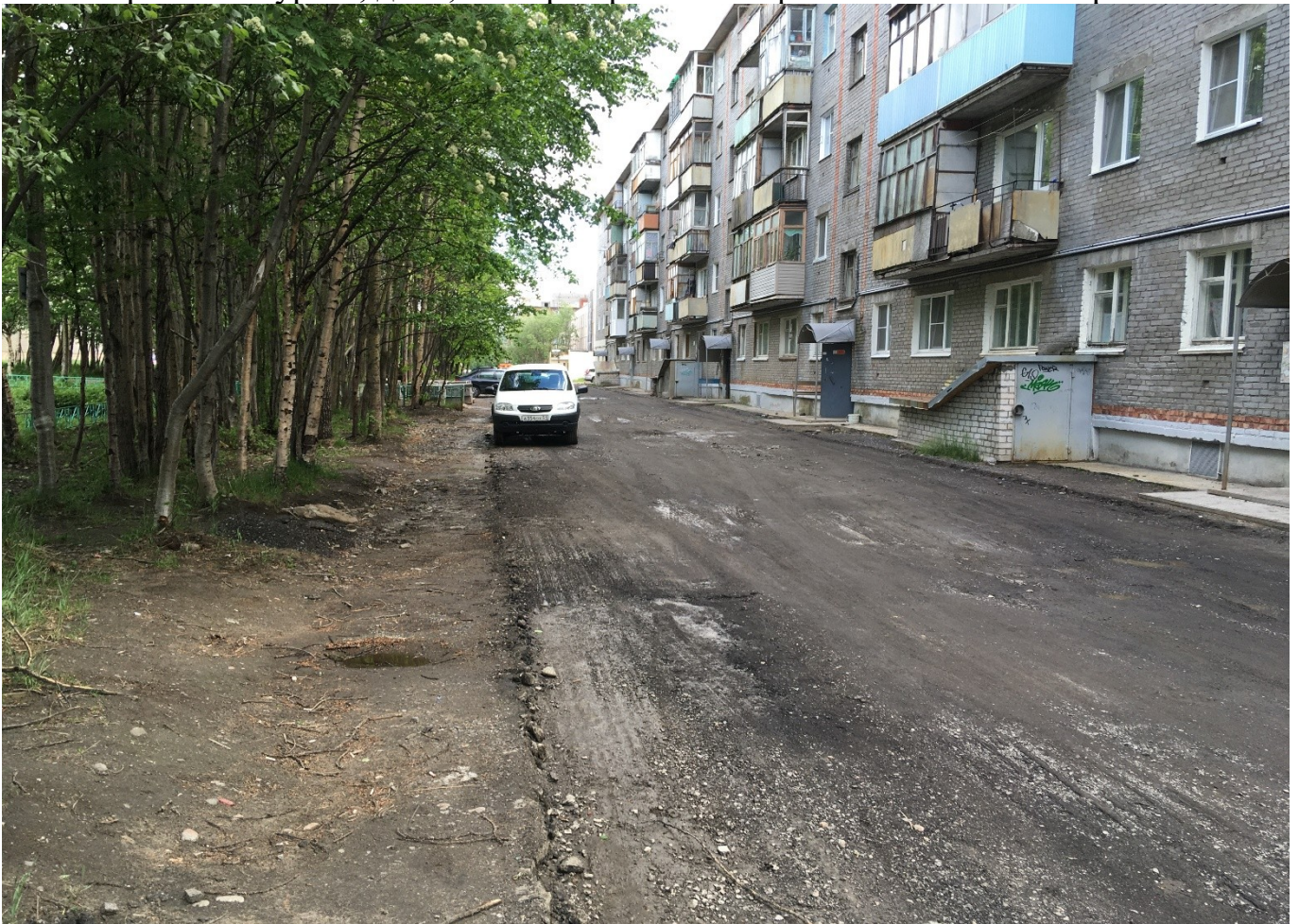
пр. Metallургов, д. 48, к.1 Фрезерование асфальтобетонного покрытия
