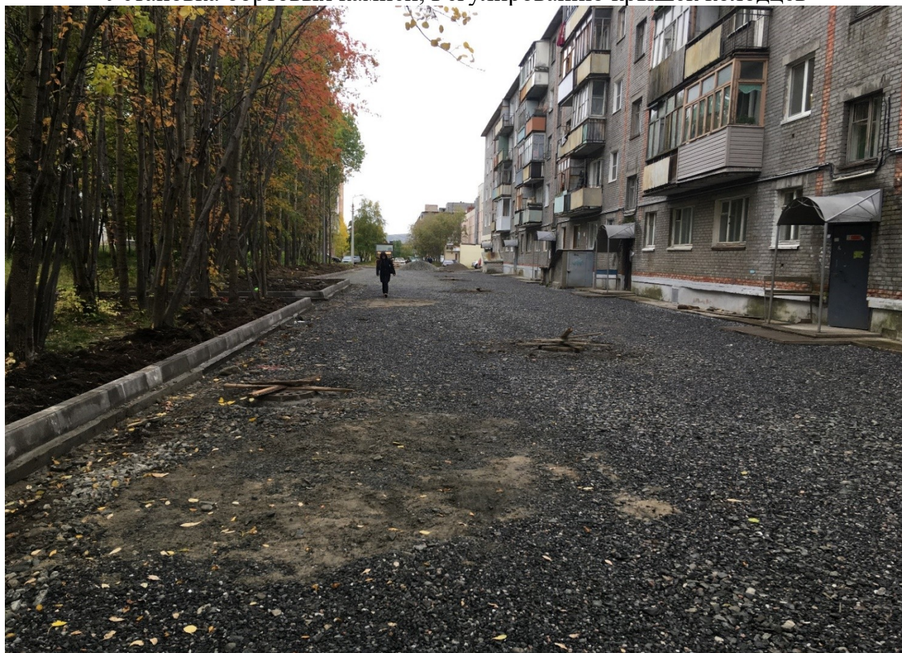
Установка бортовых камней, Регулированию крышек колодцев
