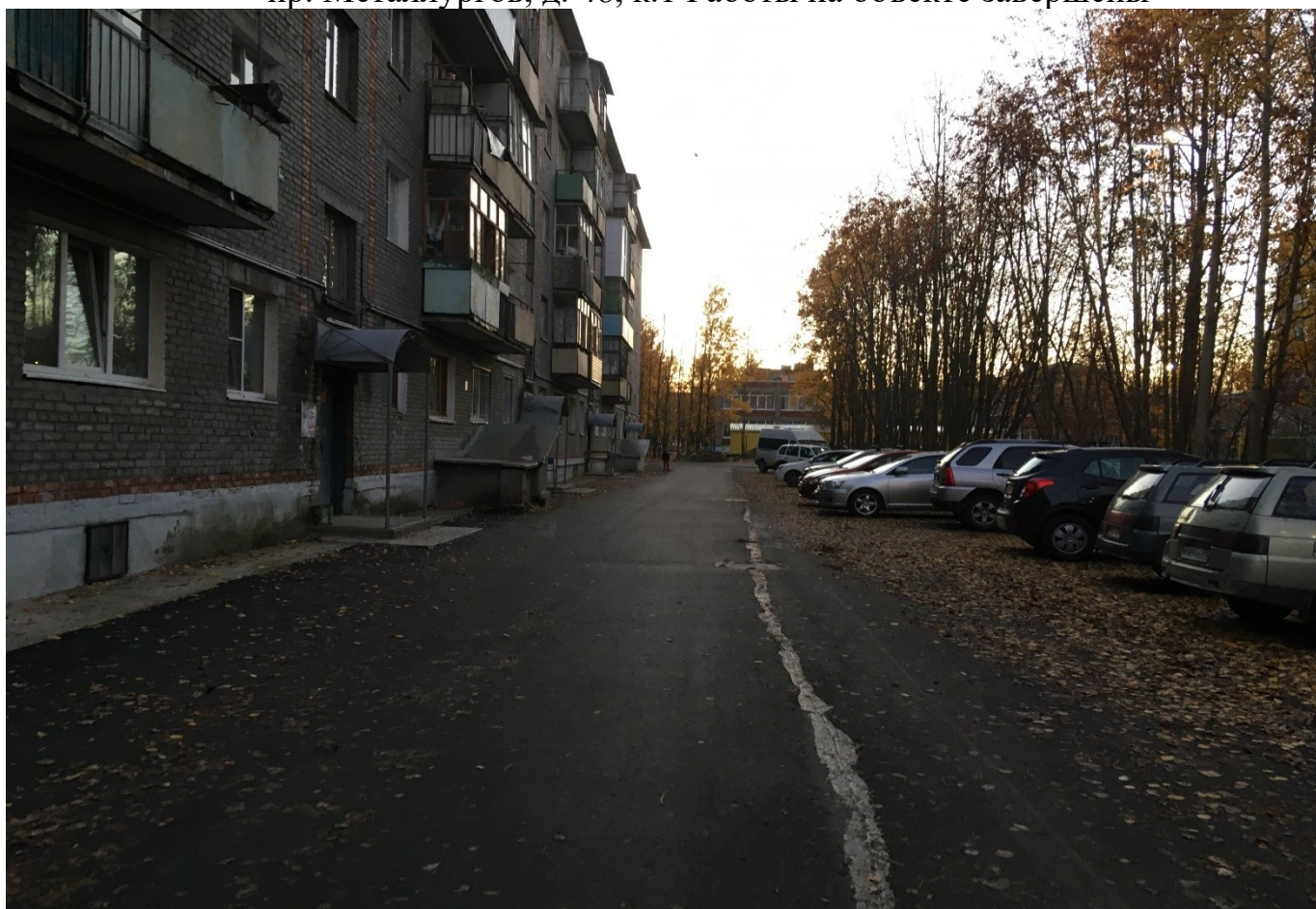
пр. Metallургов, д. 48, к.1 Работы на объекте завершены
