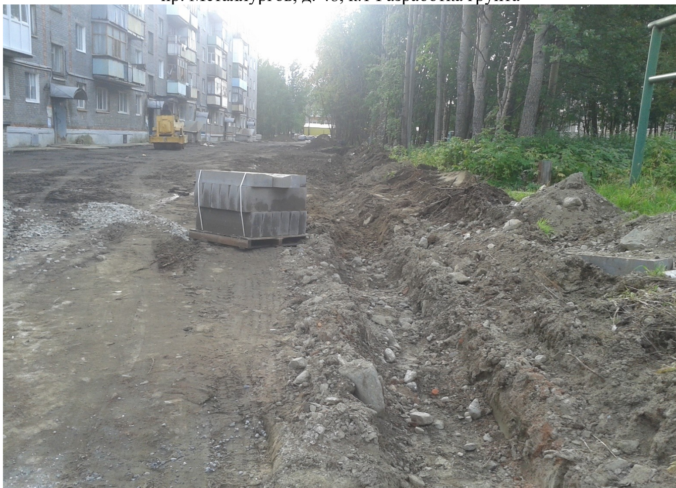
Устройство подстилающих слоев оснований из песка
