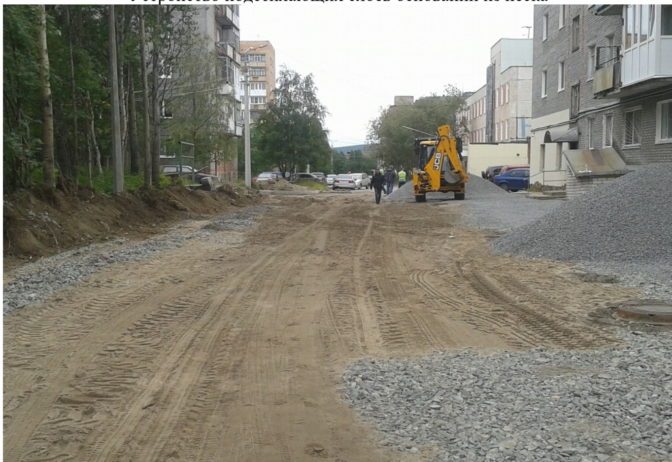
Устройство подстилающих слоев оснований из песка
