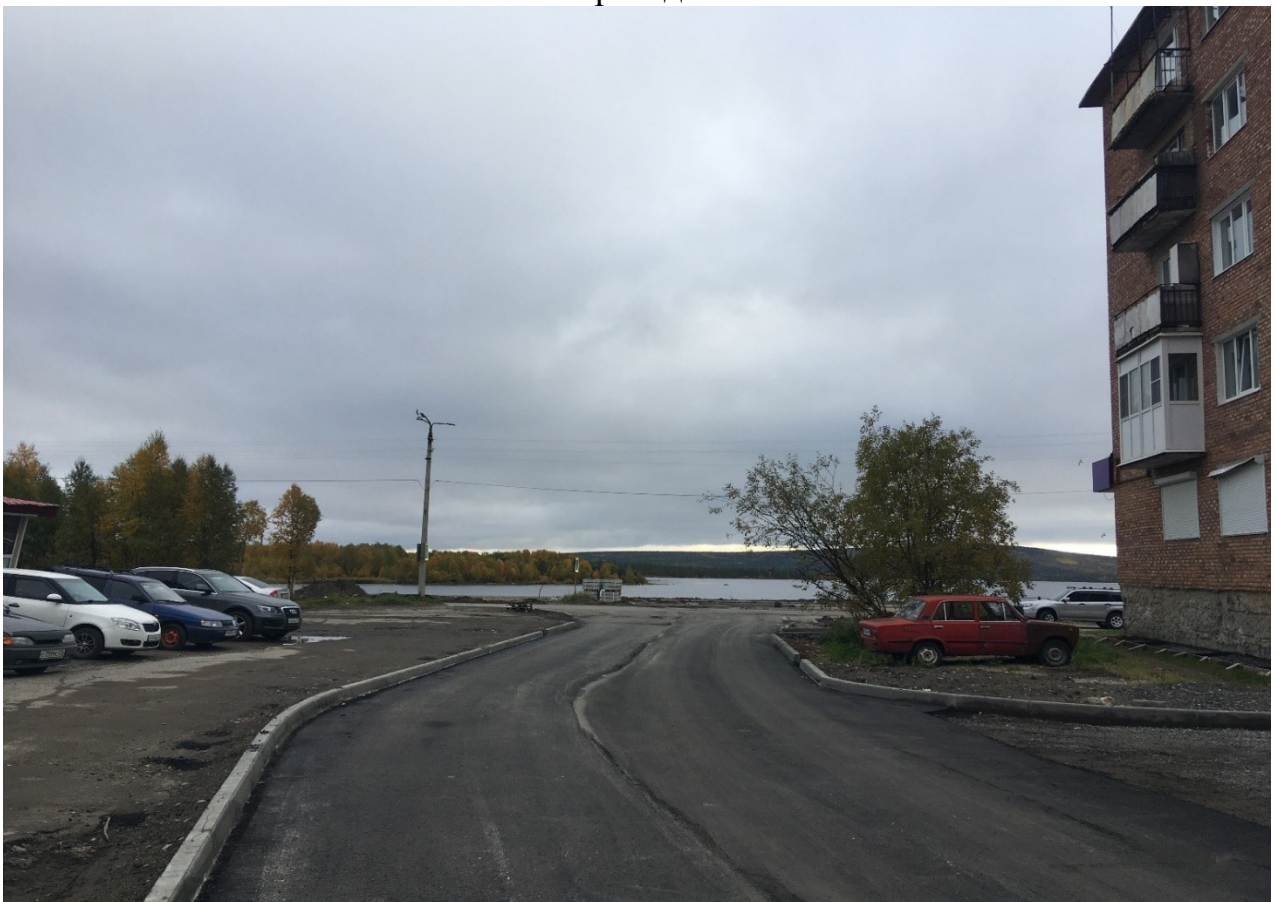
Работы на объекте завершены
