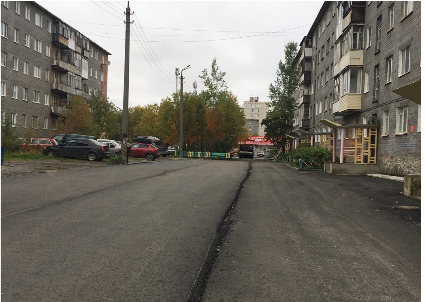
Ленинградская наб., д. 30 корпус 1 Устройство асфальтобетонного покрытия проезда
