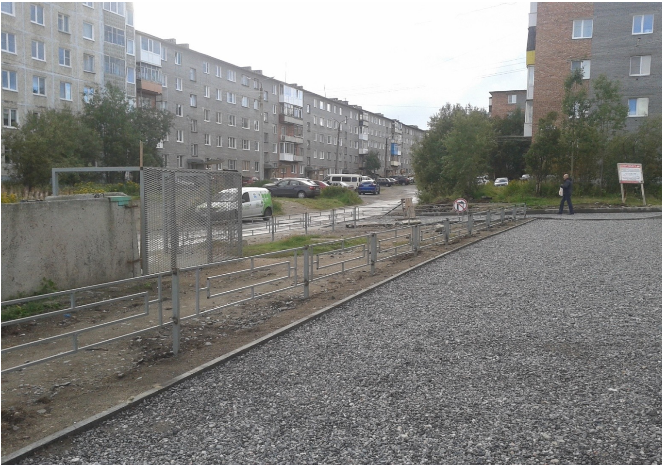
Ленинградская наб., д. 30 корпус 1 Розлив вяжущих
