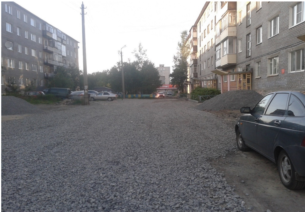
Ленинградская наб., д. 30 корпус 1 Установка бортовых камней. Регулирование высотного положения крышек колодцев
