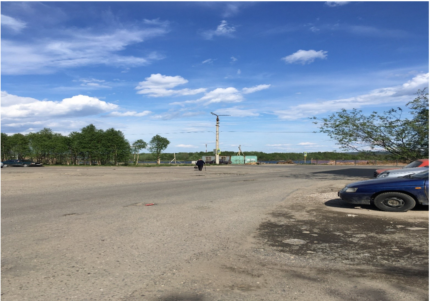
Ленинградская наб., д. 30 корпус 1 Фрезерование асфальтобетонного покрытия двора
