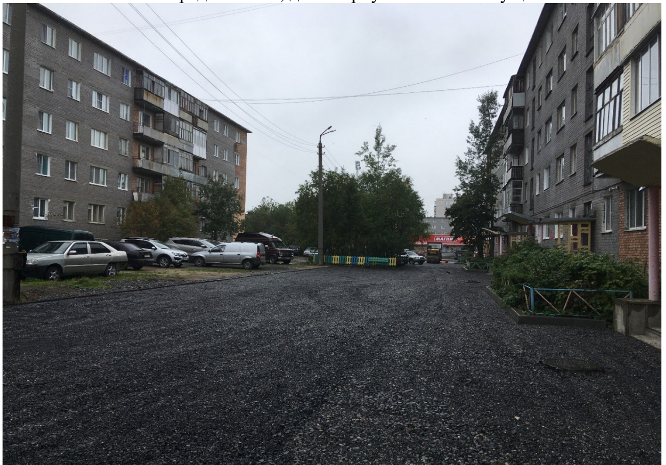
Устройство выравнивающего слоя из асфальтобетонной смеси двор
