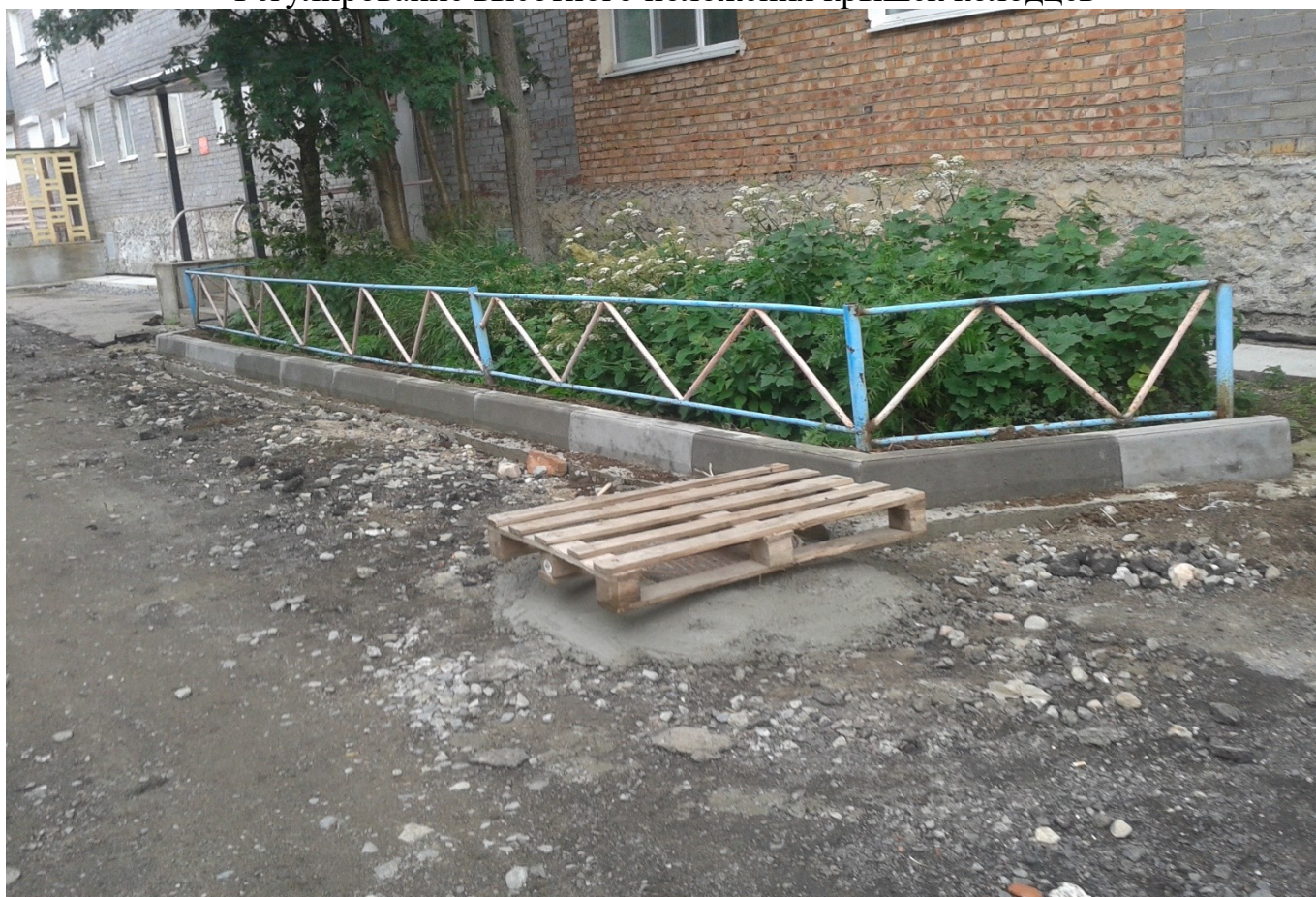
Устройство ограждения контейнерной площадки, металлического ограждения
