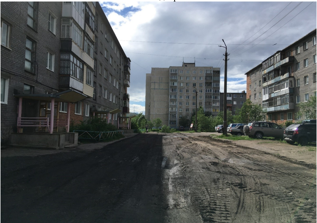
Фрезерование асфальтобетонного покрытия проезда
