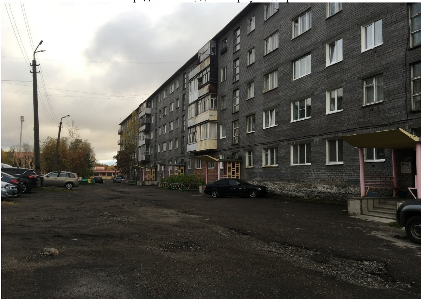
Ленинградская наб., д. 30 корпус 1 до ремонта
