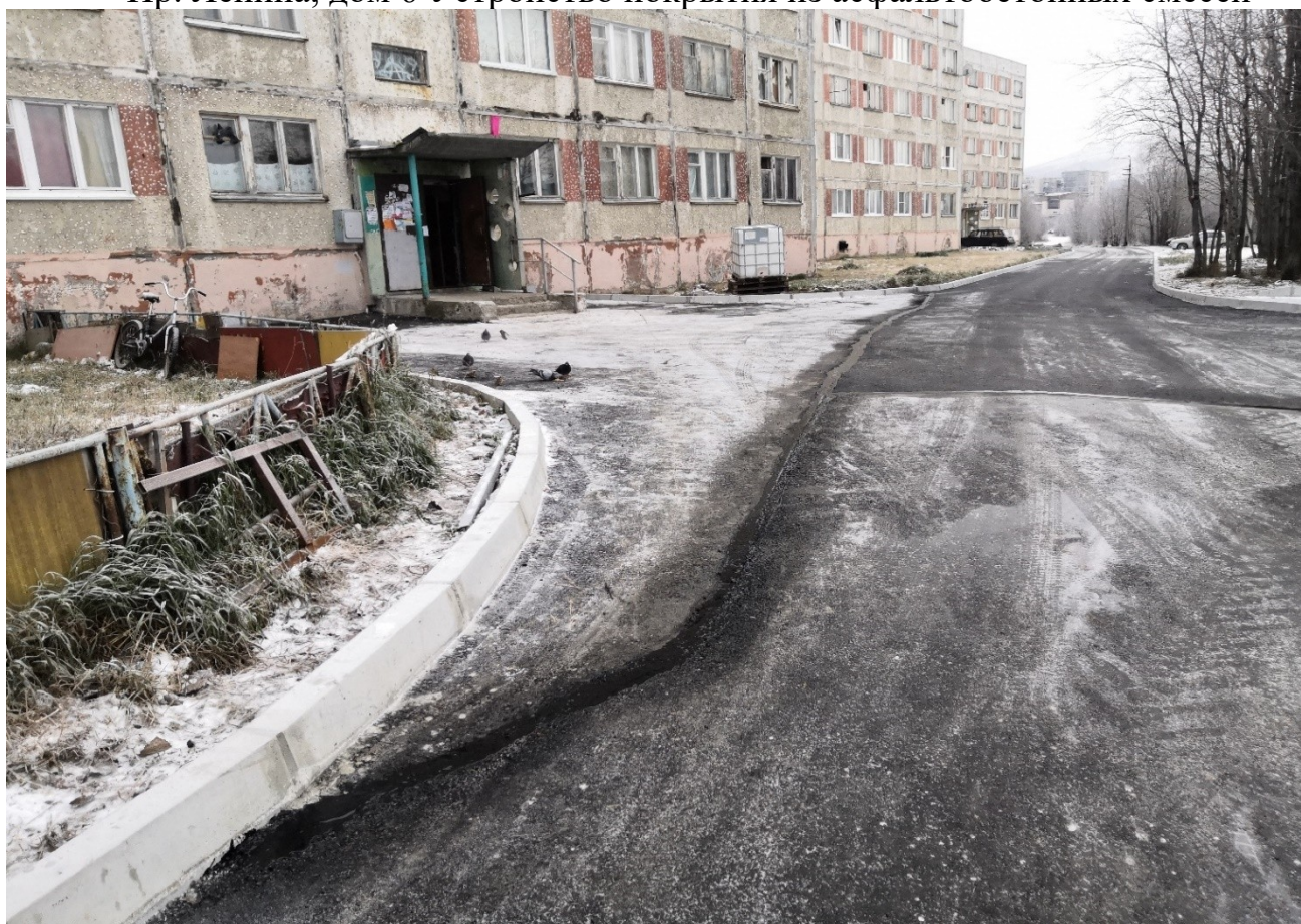
Пр. Ленина, дом 6 Устройство покрытия из асфальтобетонных смесей
