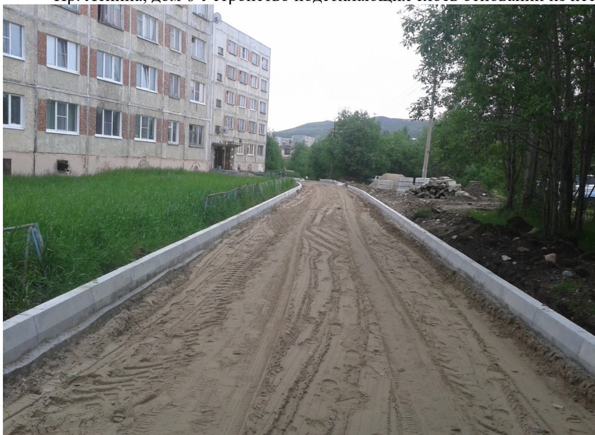
Устройство подстилающих слоев оснований из щебня
