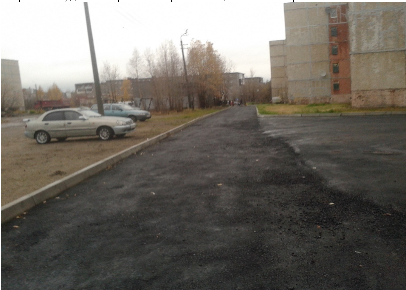
Пр. Ленина, дом 6 Устройство выравнивающего слоя из асфальтобетонной смеси
