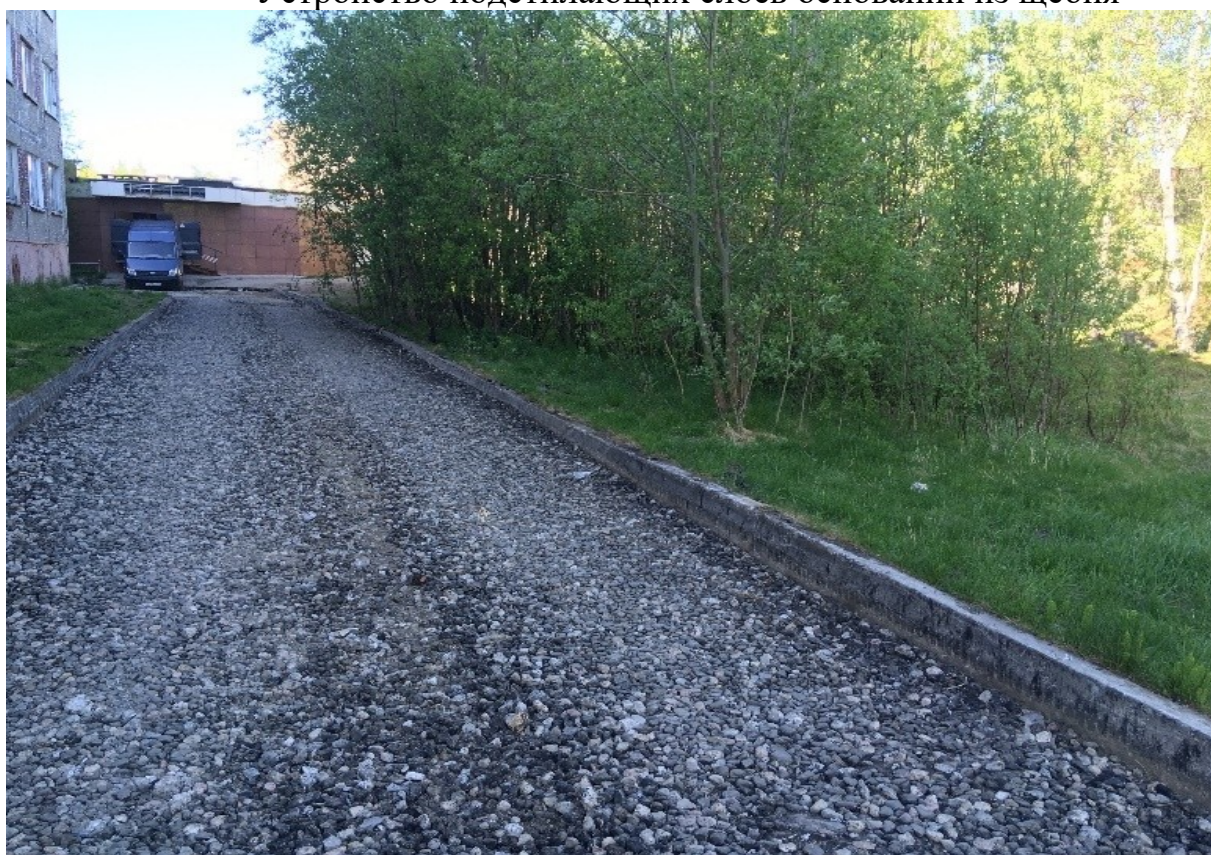
Устройство подстилающих слоев оснований из щебня
