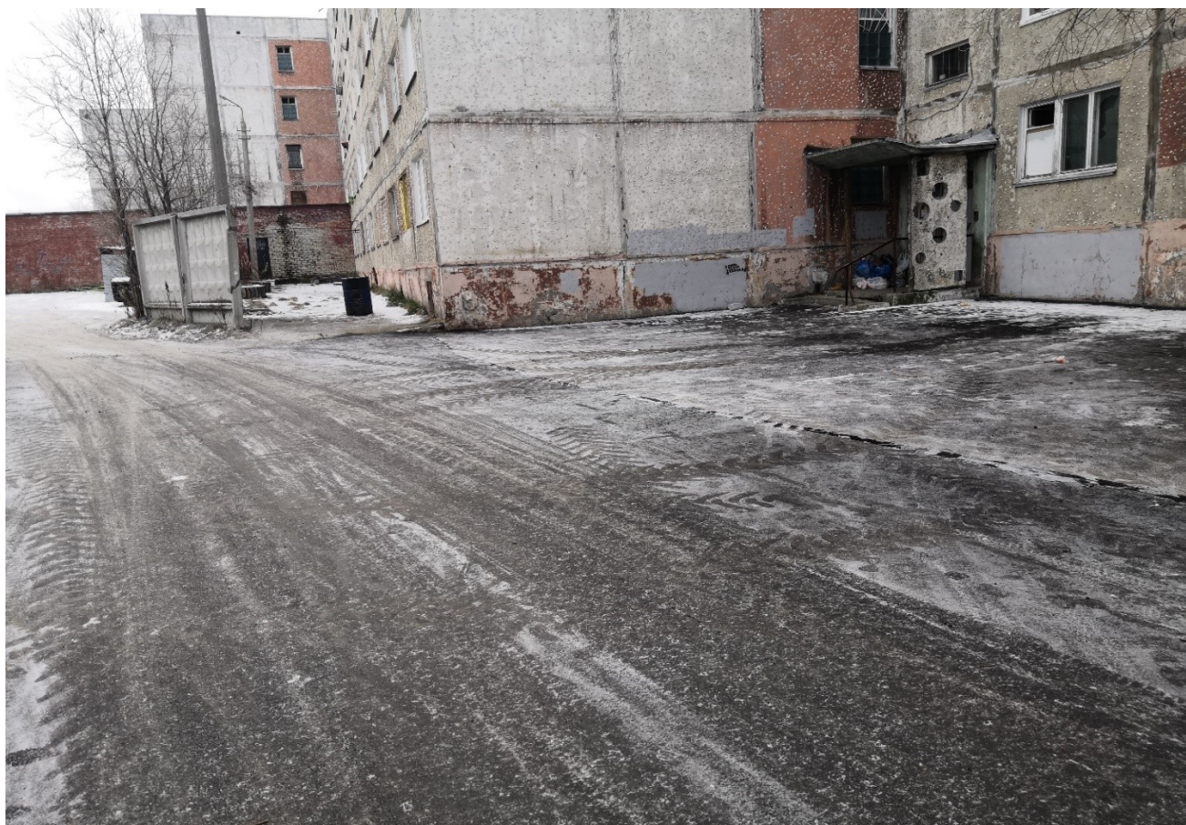
Работы на объекте завершены
