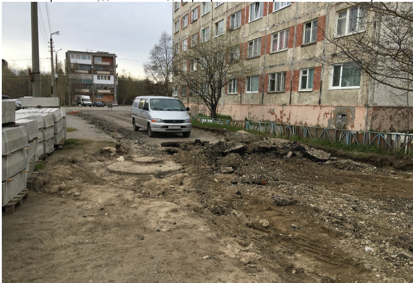
пр. Ленина, дом 6 снятие деформированных асфальтобетонных покрытий
