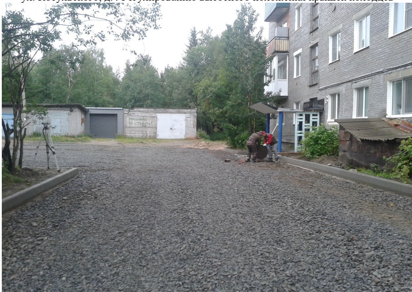
ул. Котульского, д.4 Устройство подстилающих слоев оснований из щебня
