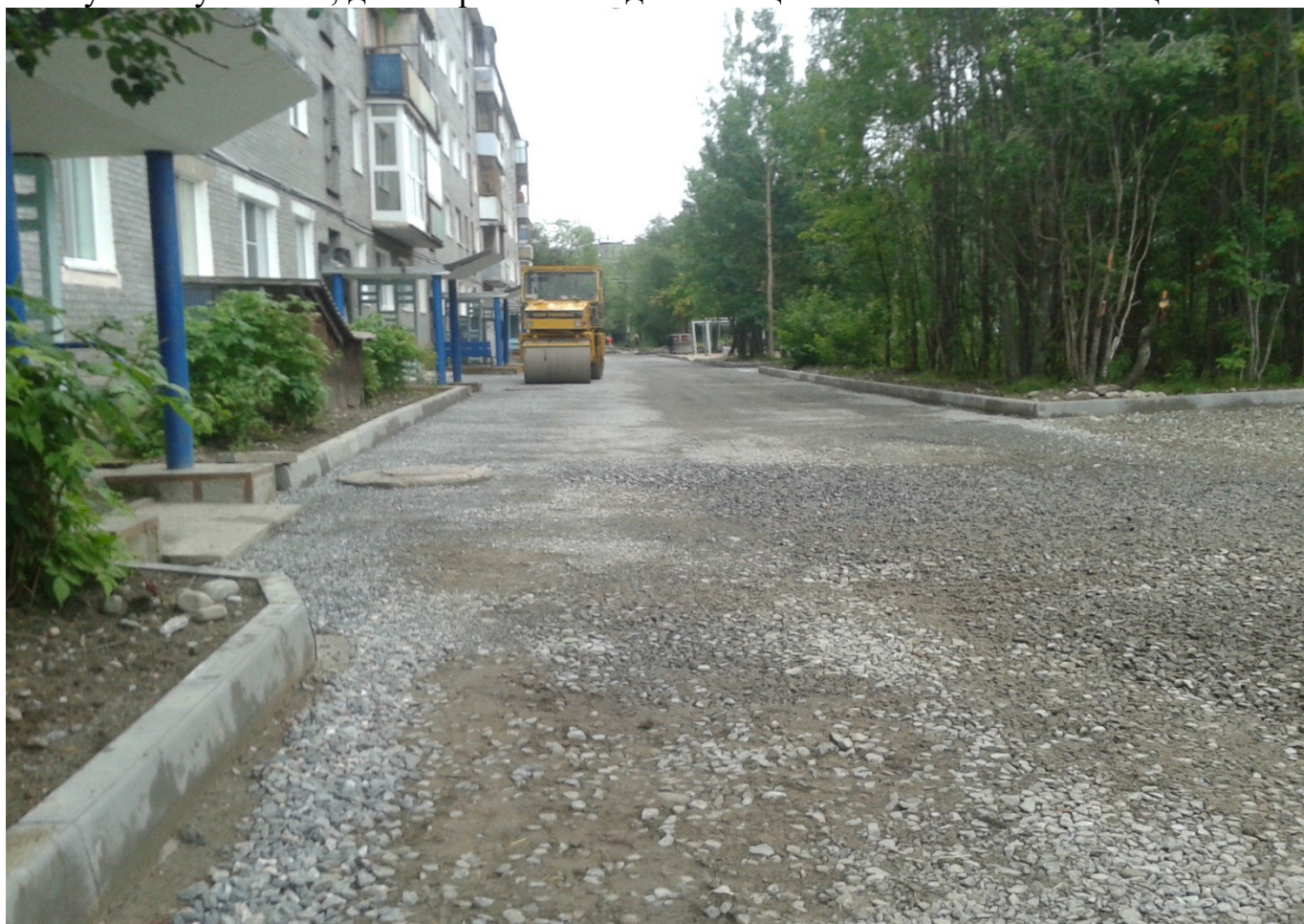
ул. Котульского, д.4 Устройство подстилающих слоев оснований из щебня
