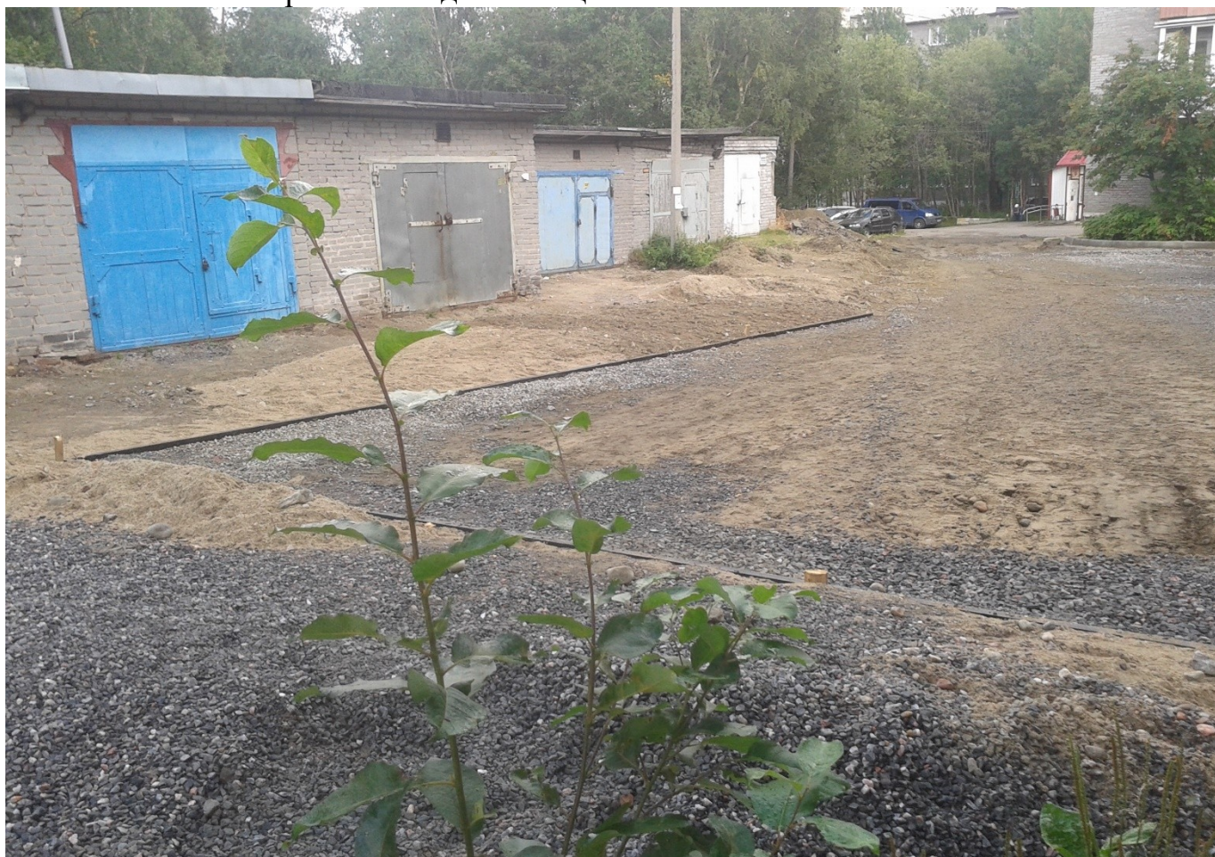
Устройство подстилающих слоев оснований из песка
