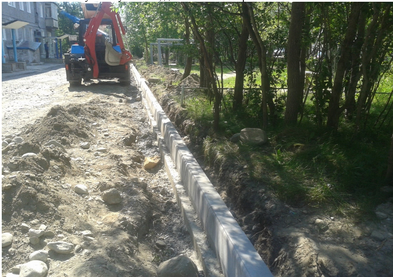
Устройство подстилающих слоев оснований из песка
