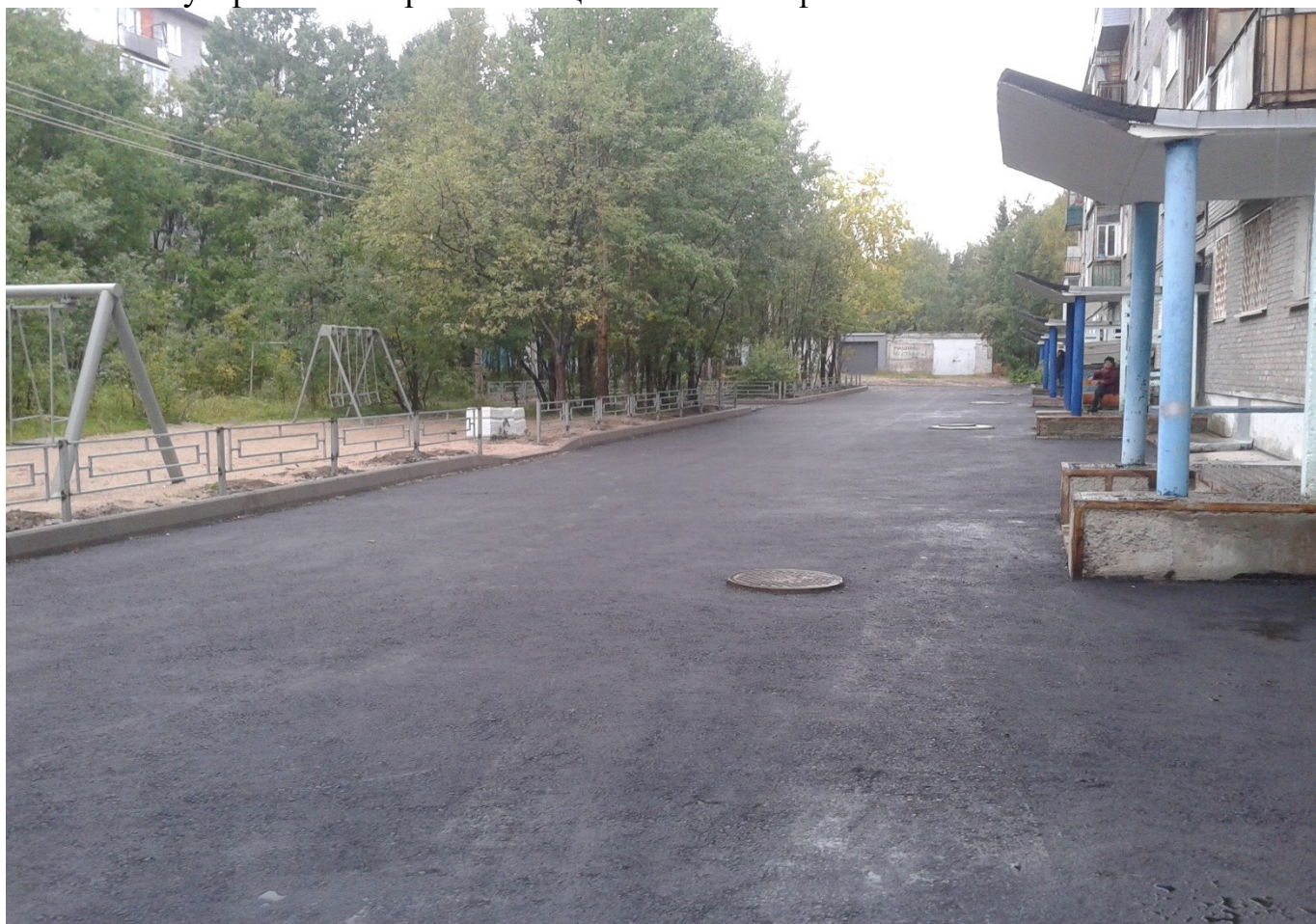
устройство выравнивающего слоя из асфальтобетонной смеси
