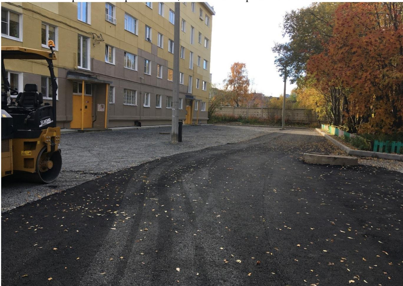
Комсомольская наб. д. 60 Устройство покрытия из асфальтобетонных смесей
