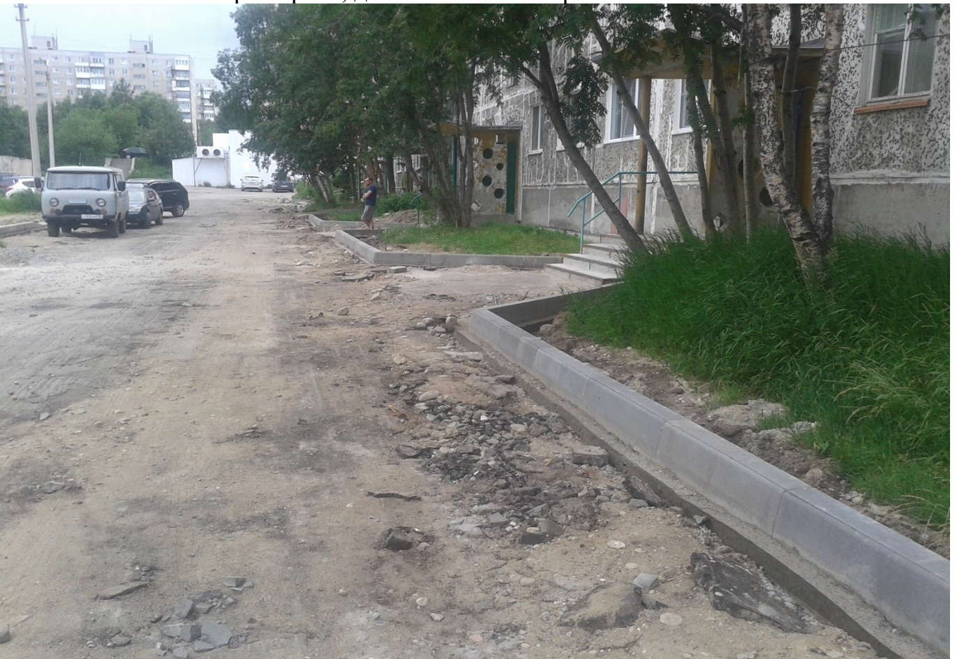
Устройство подстилающих слоев оснований из щебня новое покрытие
