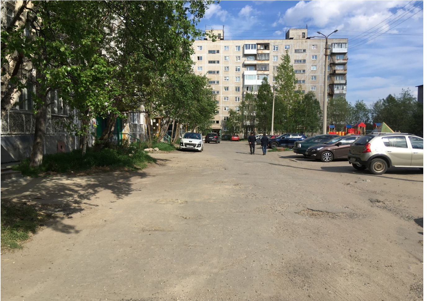
пр. Кирова, д. 31 Фрезерование асфальтобетонного покрытия
