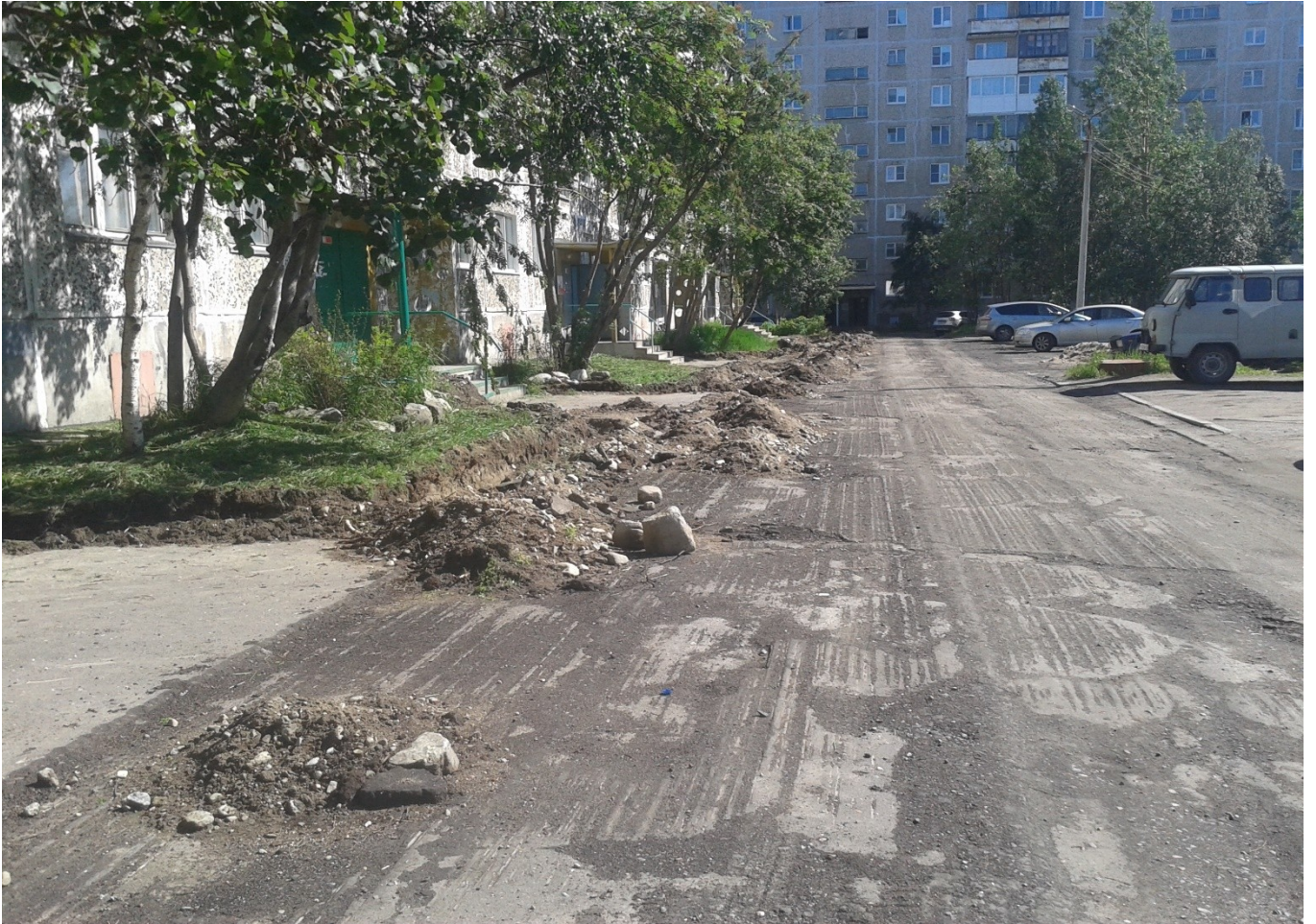
пр. Кирова, д. 31 Установка бортовых камней
