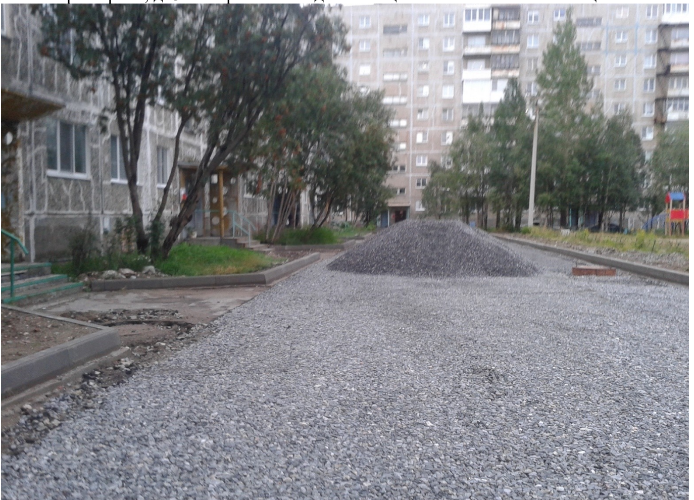
пр. Кирова, д. 31 Устройство подстилающих слоев оснований из щебня
