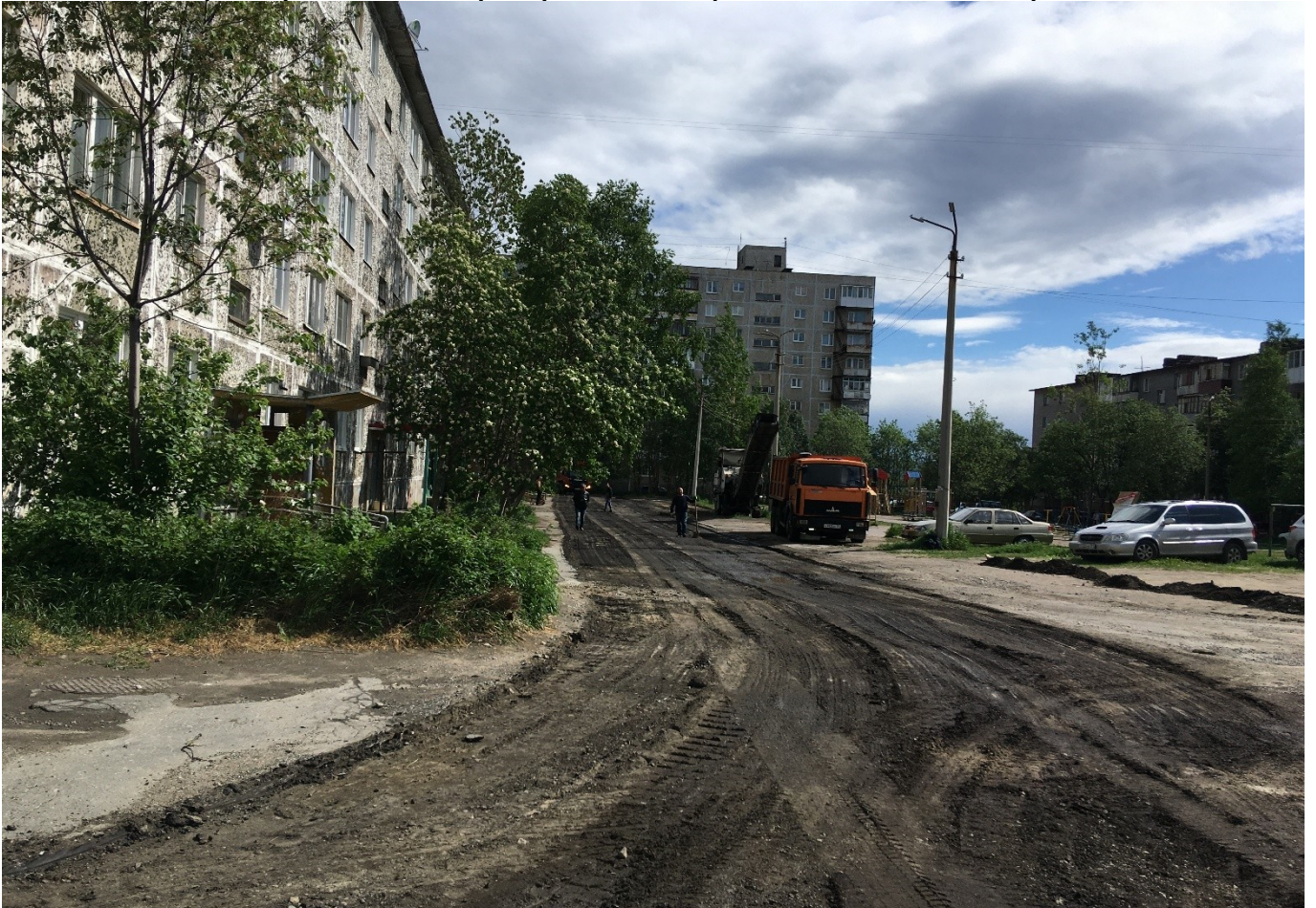
Разборка бортовых камней
