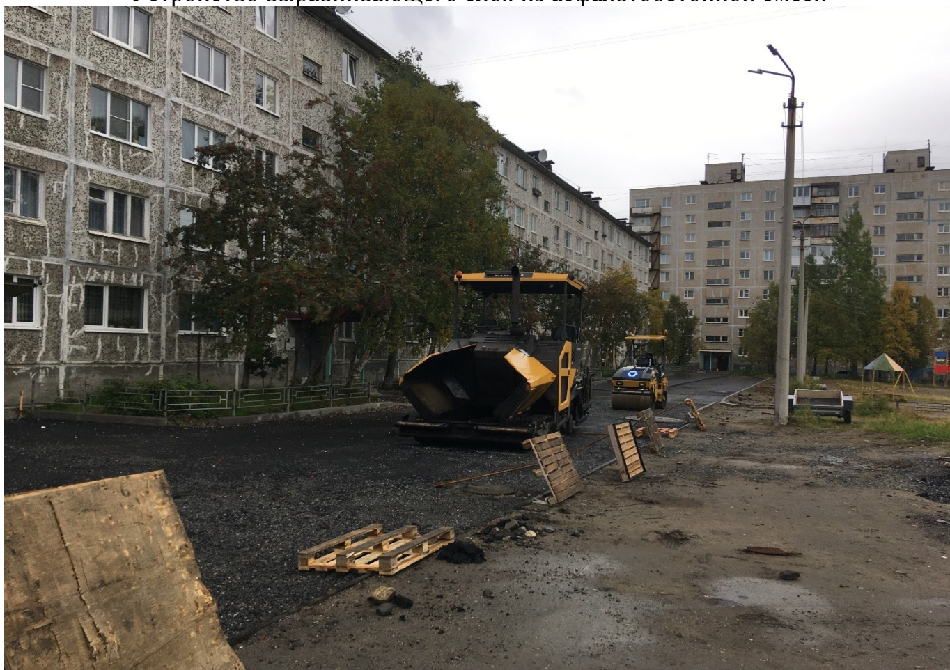
пр. Кирова, д. 31 Устройство покрытия из асфальтобетонных смесей
