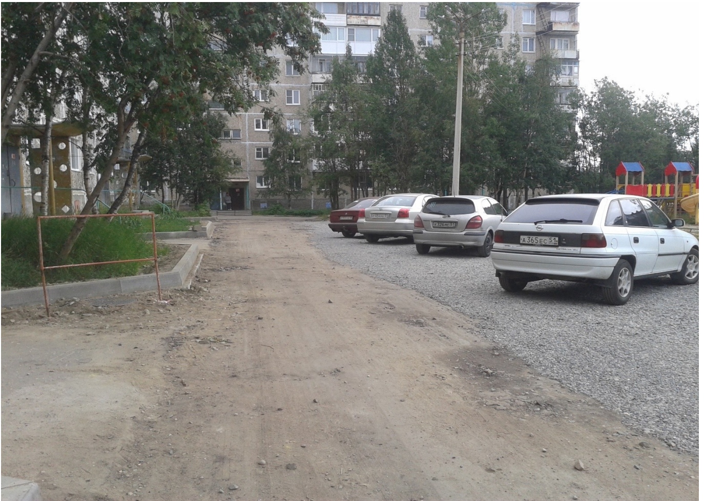
пр. Кирова, д. 31 Устройство подстилающих слоев оснований из щебня
