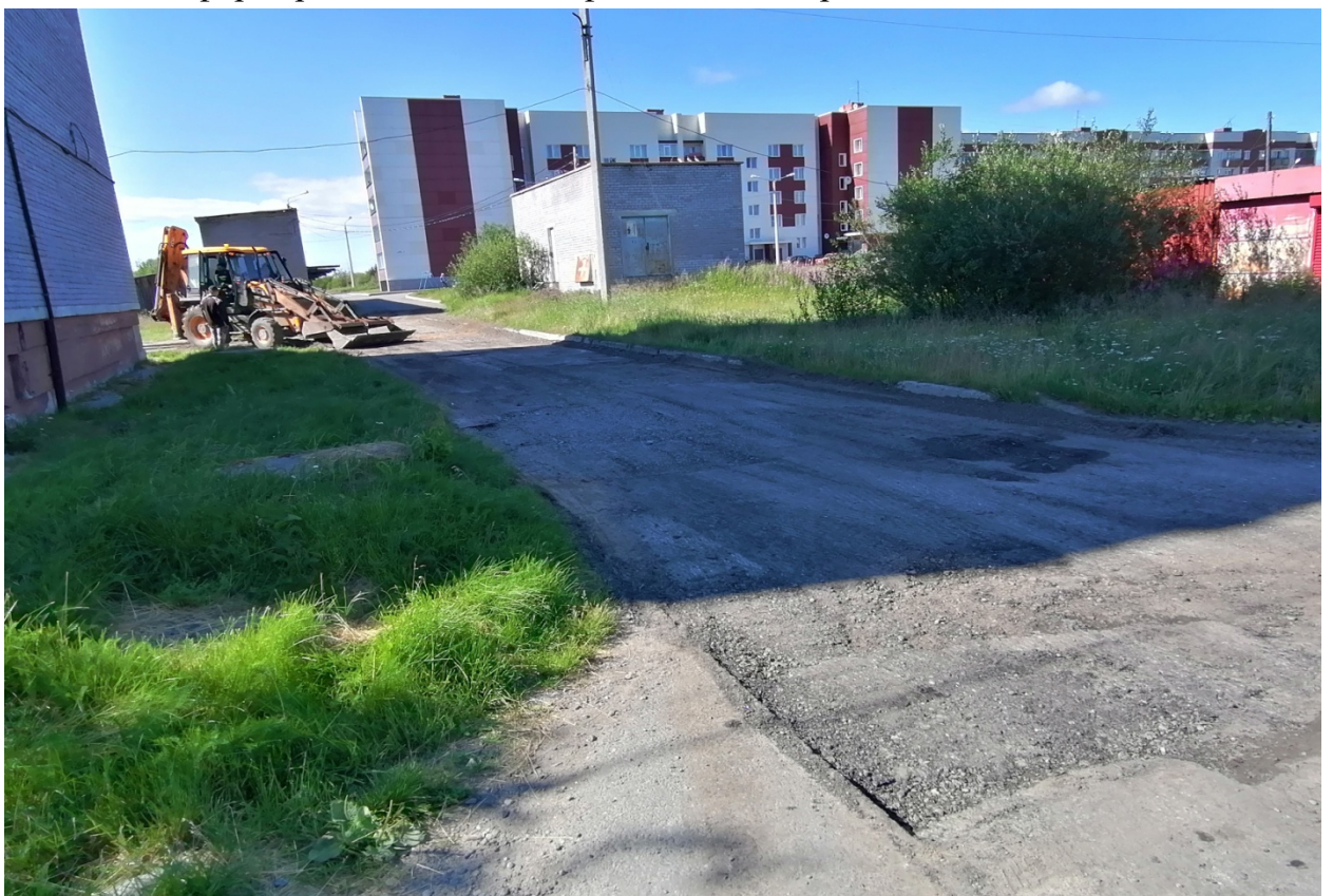
1. Снятие деформированного слоя асфальтового покрытия
