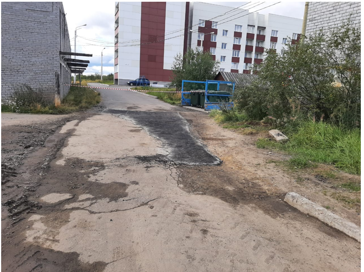
1. Снятие деформированного слоя асфальтового покрытия
