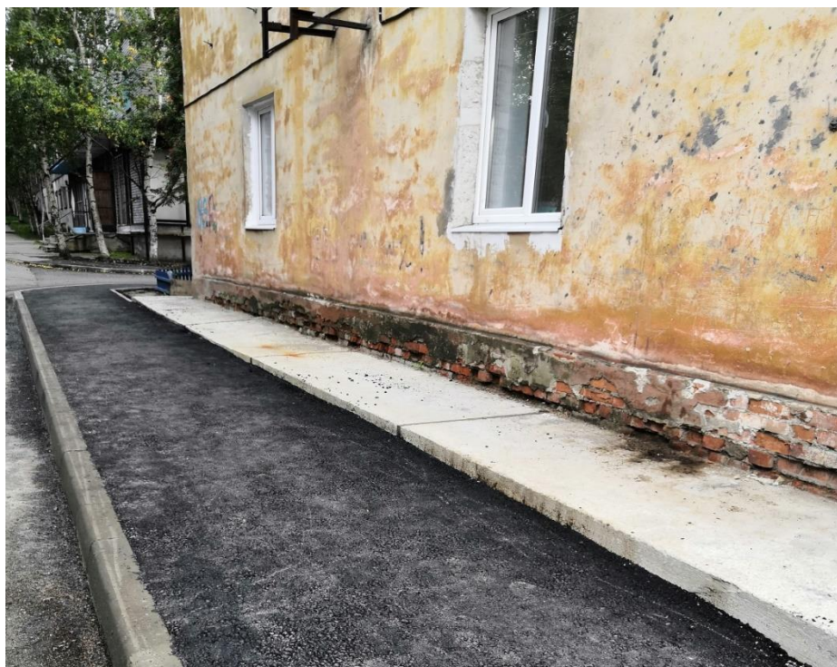
После проведения работ
