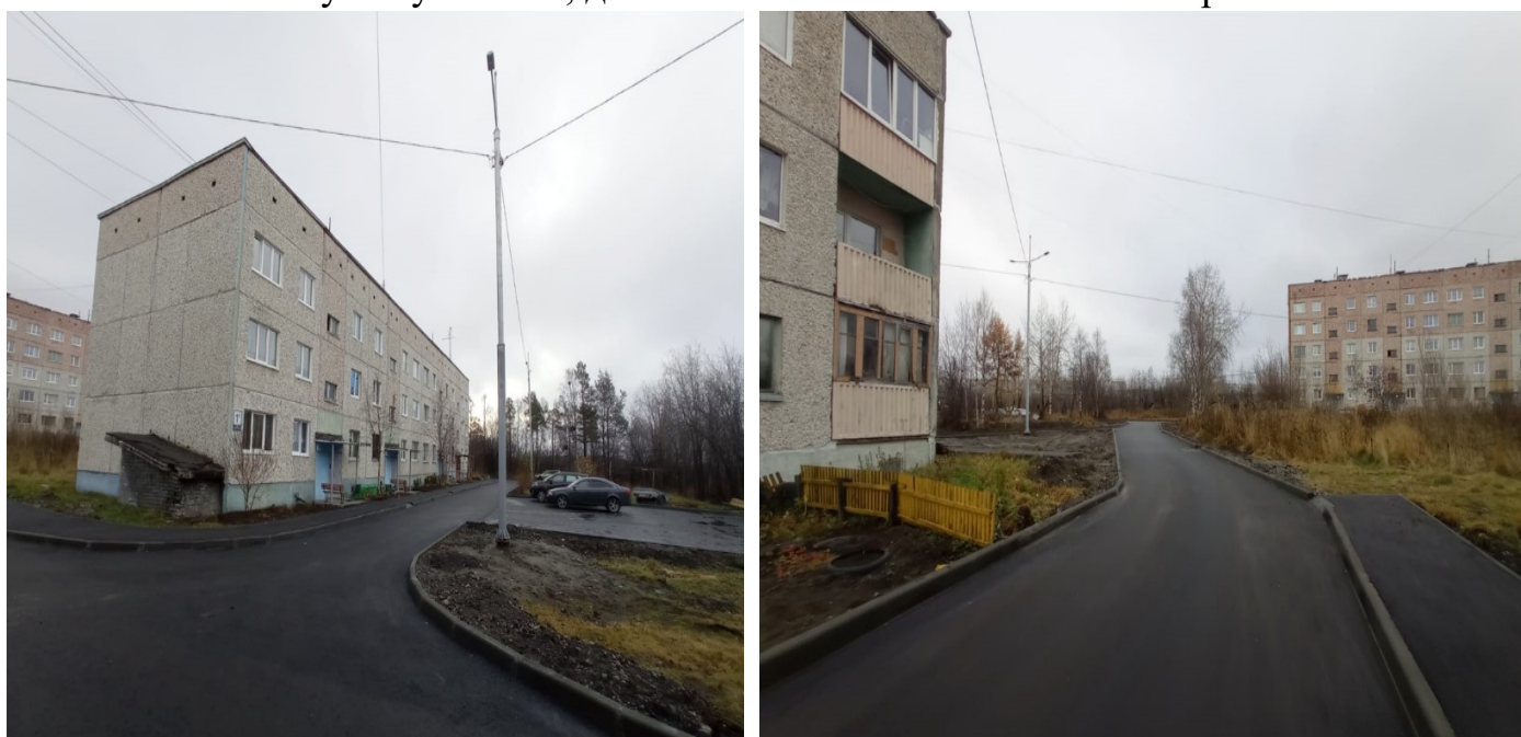
ул. Путьская, д. 1а после окончания выполнения работ
