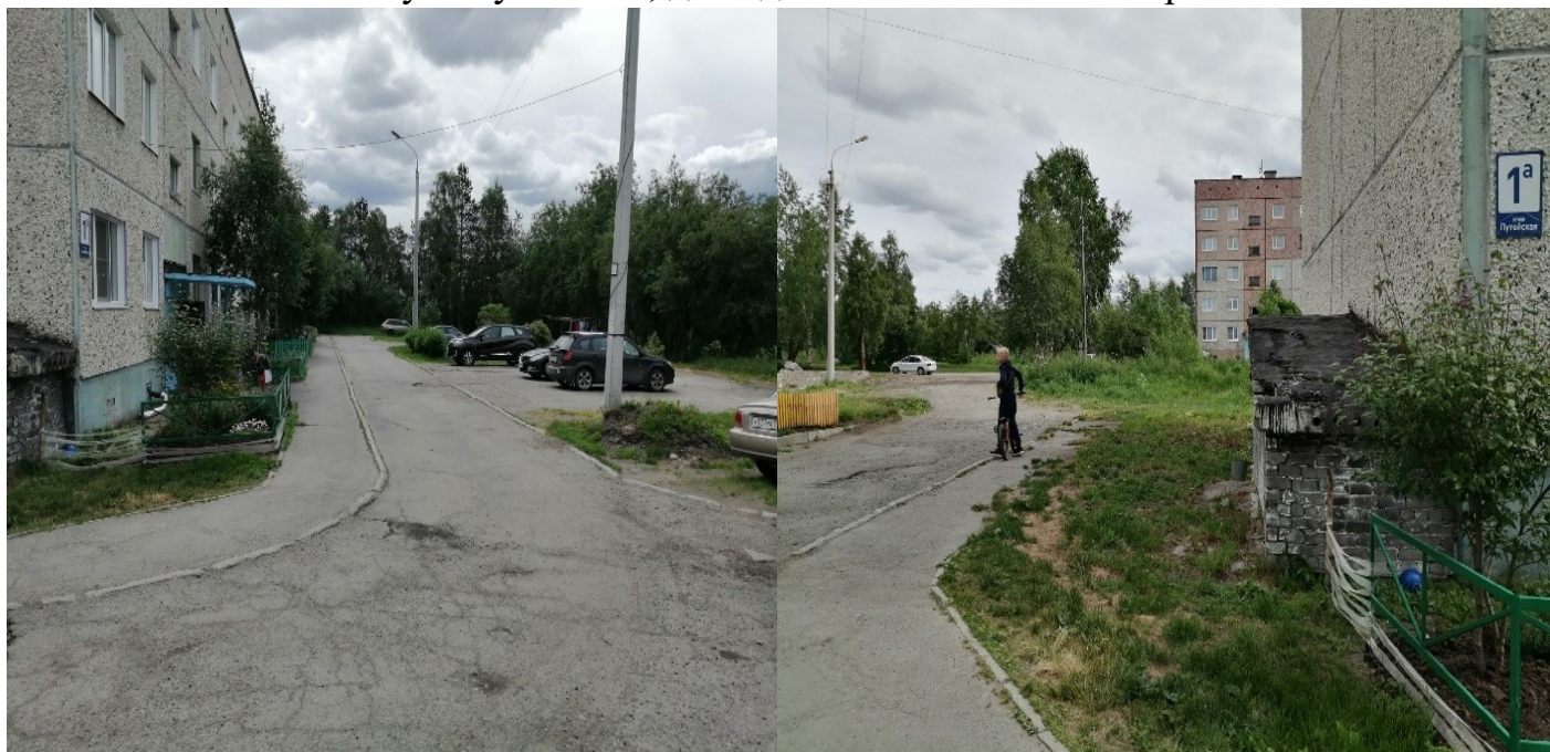
ул. Путьская, д. 1а до начала выполнения работ
