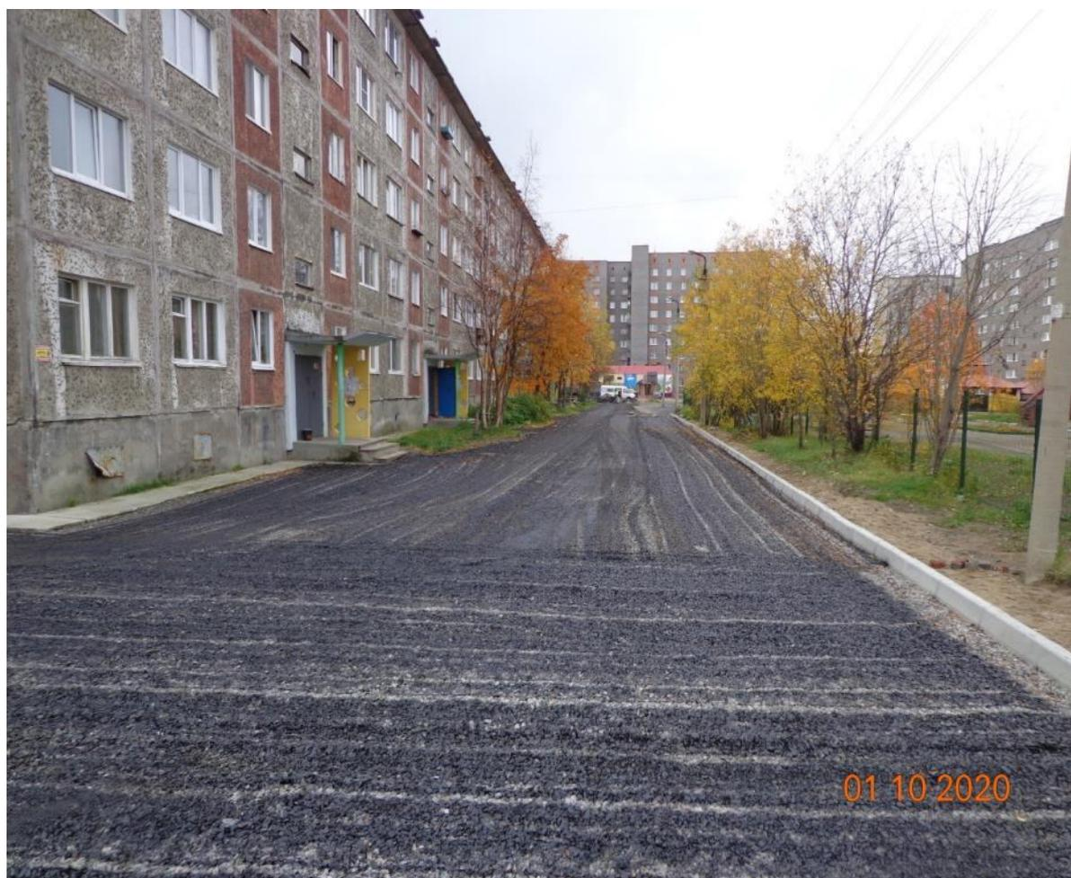
**По состоянию на 01.10.2020 (устройство асфальтобетонного покрытия)**
