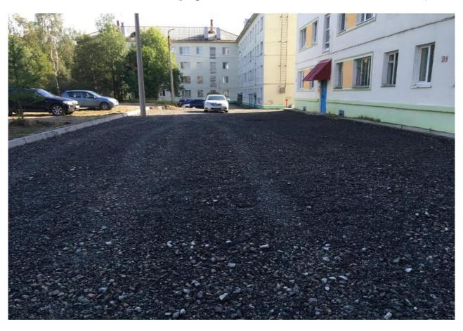
По состоянию на 29.09.2020 (устройство покрытия из асфальтобетонных смесей)
