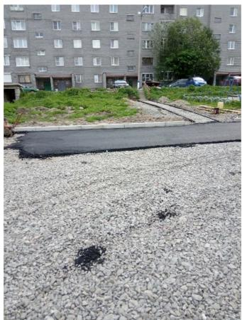
Выполнены все подготовительные работы (подготовка оснований, замена бортовых камней и т.п.) выполняются работы по устройству покрытия из горячих асфальтобетонных смесей
