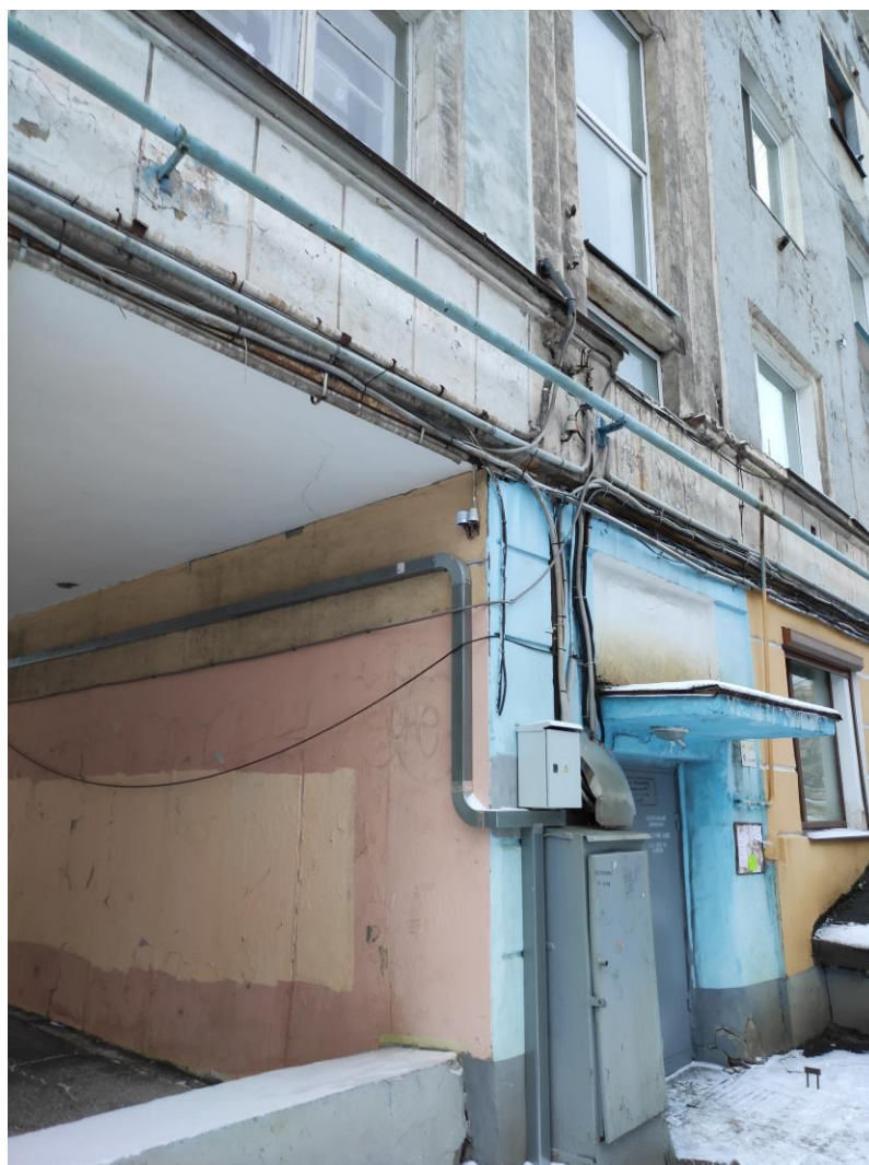
Фото 8. Фрагмент дворового фасада (шкаф с разъединителем и выход существующих кабелей на фасад)
