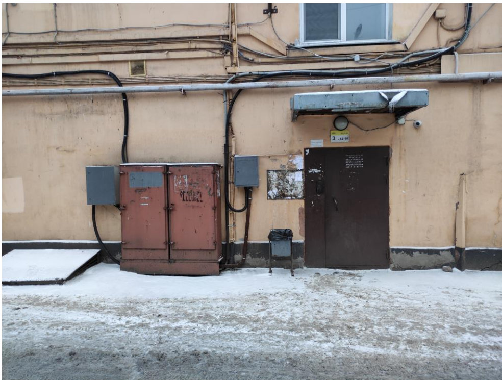
Фото 6. Фрагмент дворового фасада (щит с разъединителем и существующие выходы кабелей на фасад)
